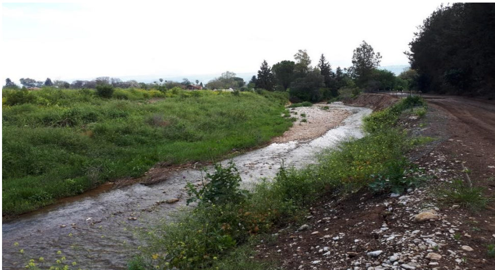
איור 2 - התחתרות חריפה עד היווצרות קיר, הצטברות סחף וסכנה לקריסת גדות
