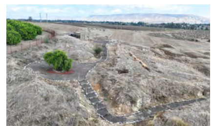
איור 6: האתר לקראת סיום ביצוע שלב א': רחבת עץ השיזף ובעומק רחבת התצפית וצריף המשלחות. רשות ניקוז כינרת, נובמבר 2023
